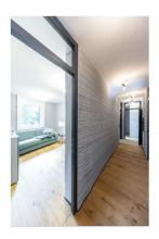
Der Holzboden wurde auf einer Trittschalldämmung schwimmend verlegt. (Bild: PERI)
